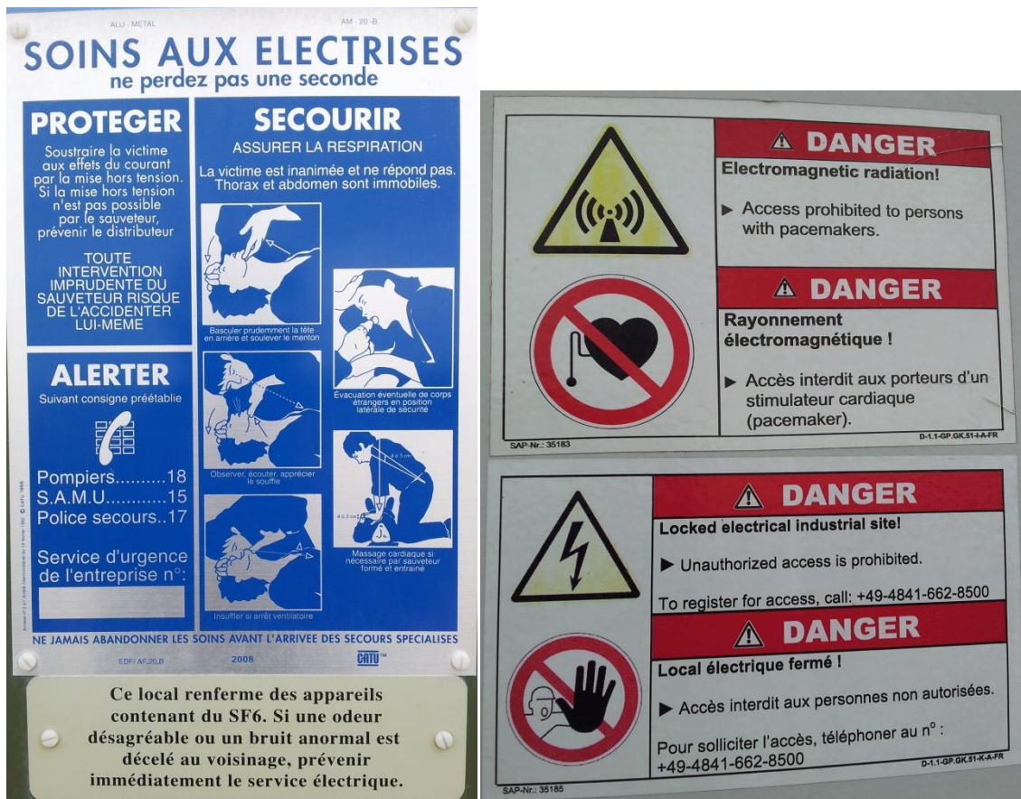
Figure 9 - Panneaux d'avertissement sur les portes des aérogénérateurs et du poste de livraison
